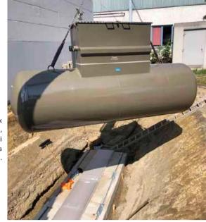
Der Flüssiggastank wurde so eingelagert, dass er selbst bei Hochwasser bestens geschützt ist.
