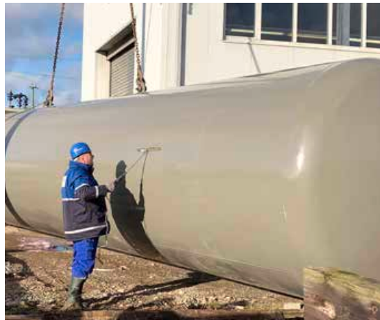
Einlagerung und Installation des 28,5-Tonnen-Flüssiggastanks auf dem RAW-Chemnitz-Gelände
