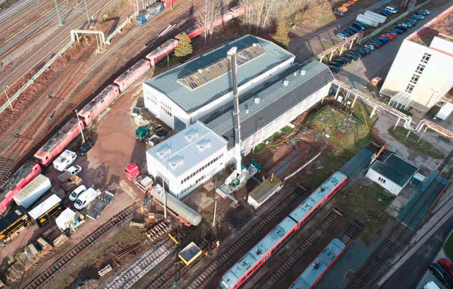
Blick auf das RAW-Gelände bei der Einlagerung des Tanks
