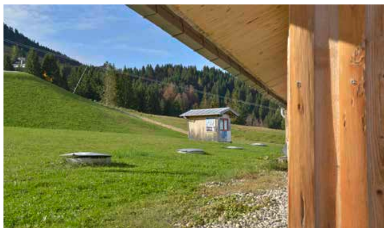
Die vier Flüssiggastanks sind hinter dem Haus unterirdisch eingelagert. Zu sehen sind nur die Domschächte – über sie werden die Behälter turnusmäßig betankt.
