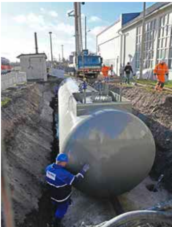
Einlagerung und Installation des 28,5-Tonnen-Flüssiggastanks auf dem RAW-Chemnitz-Gelände
