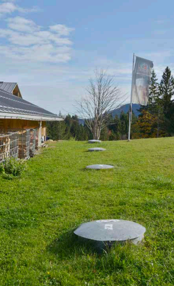
Die vier Flüssiggastanks sind hinter dem Haus unterirdisch eingelagert. Zu sehen sind nur die Domschächte – über sie werden die Behälter turnusmäßig betankt.
